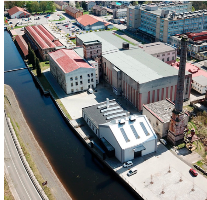
Letecký pohled na areál přádelny
