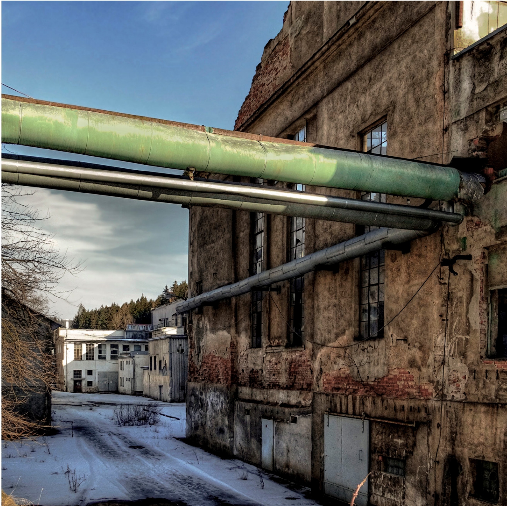
Bývalá, dnes již asanovaná, papírna Prokop, Loučovice
