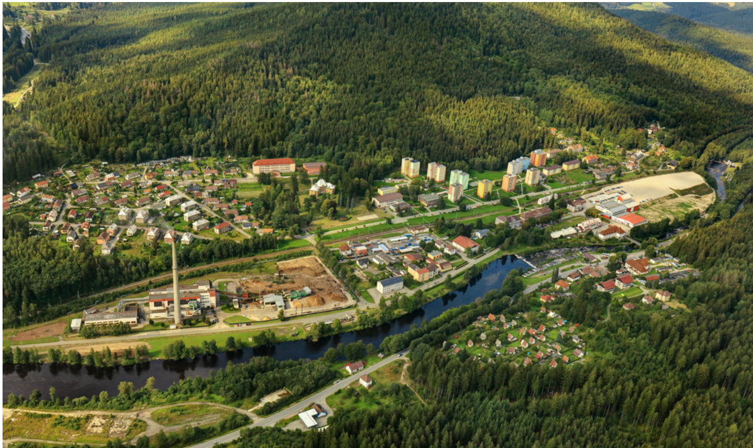
Loučovice s asanovanými brownfieldy - vlevo dole bývalá pila a dřevosklad, nad ním teplárna a zcela vpravo plocha po zbourané papírně Vltavský mlýn
