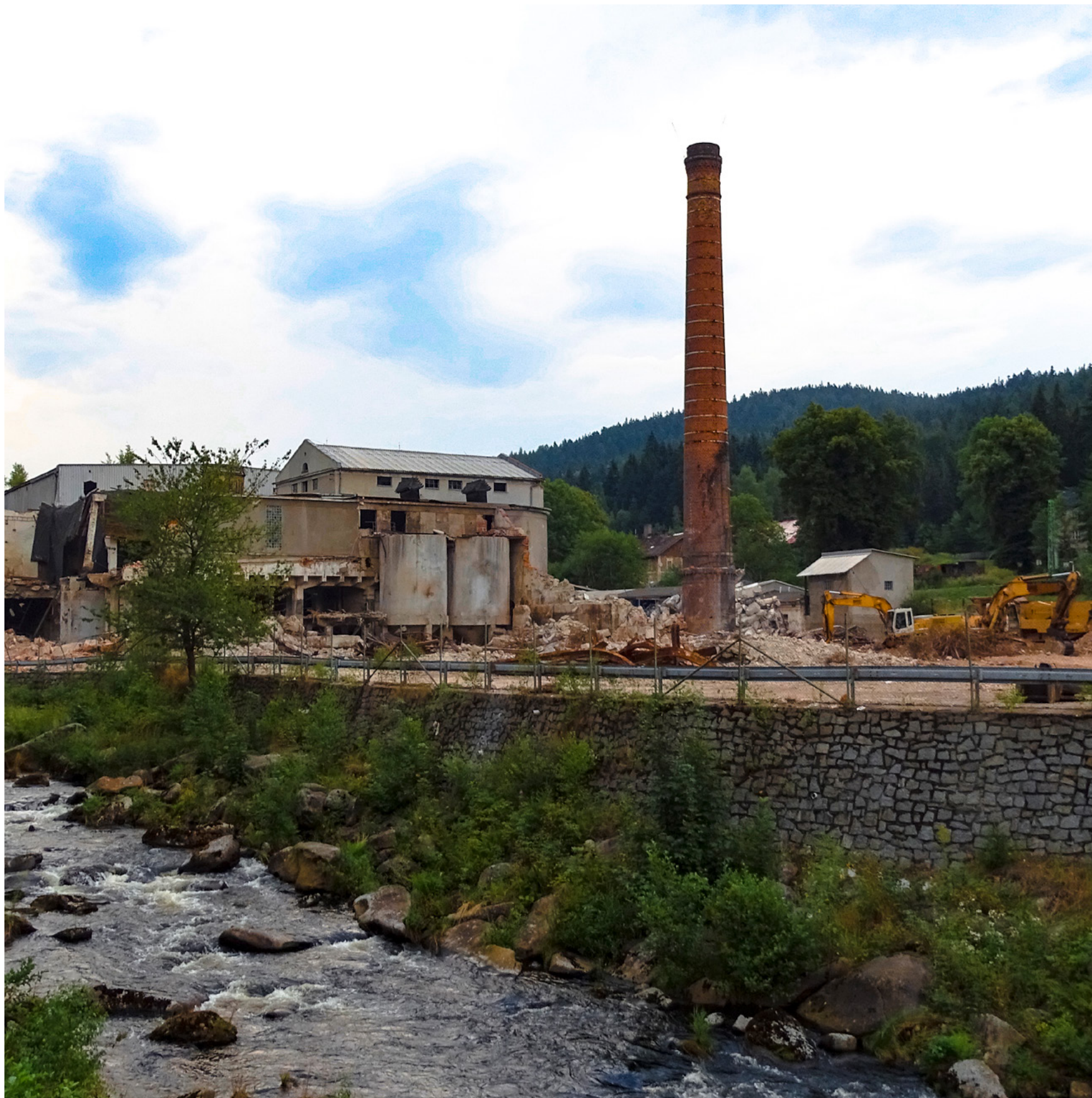
Bourání bývalé papírny Prokop v Loučovicích
