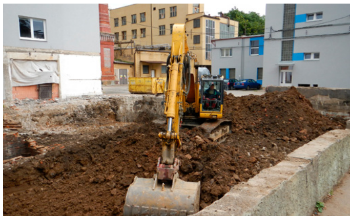
Probíhající sanační práce v areálu VUAB Pharma a.s.
