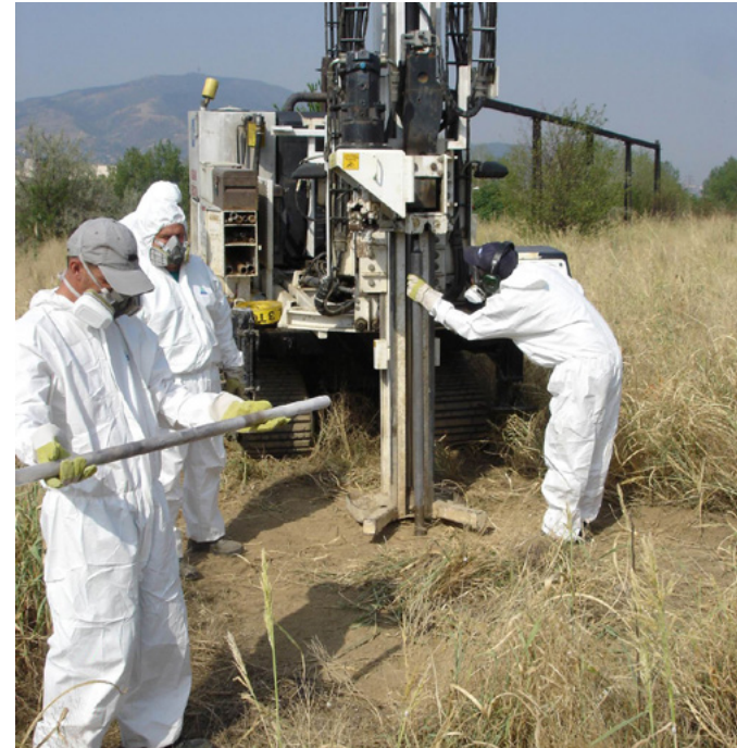
Provádění sond pro odběr vzorků zemin z podloží skládky
