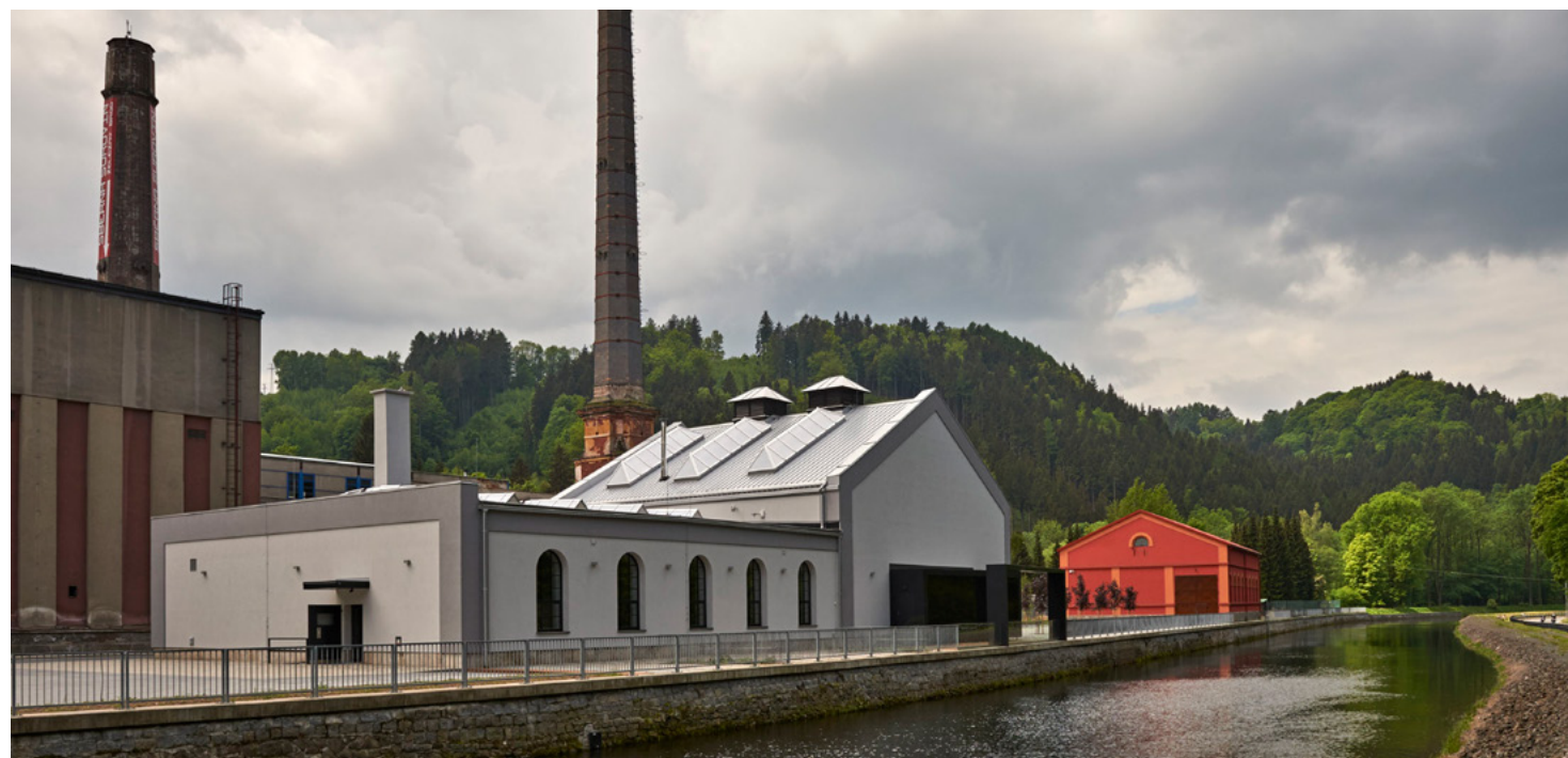
Pohled na zrekonstruovaný objekt kotelny. V pozadí galerie světoznámých sklářů Jana Libenského a Jaroslavy Brychtové.
