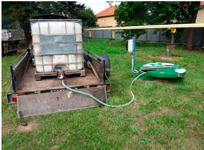
Sanační práce: Aplikace syrovátky v areálu Jihostroj a.s.
