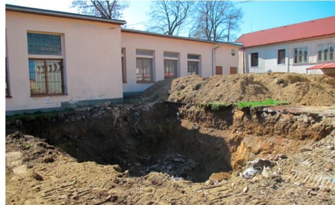
Odtěžení kontaminované zeminy v areálu Jihostroj a.s.
