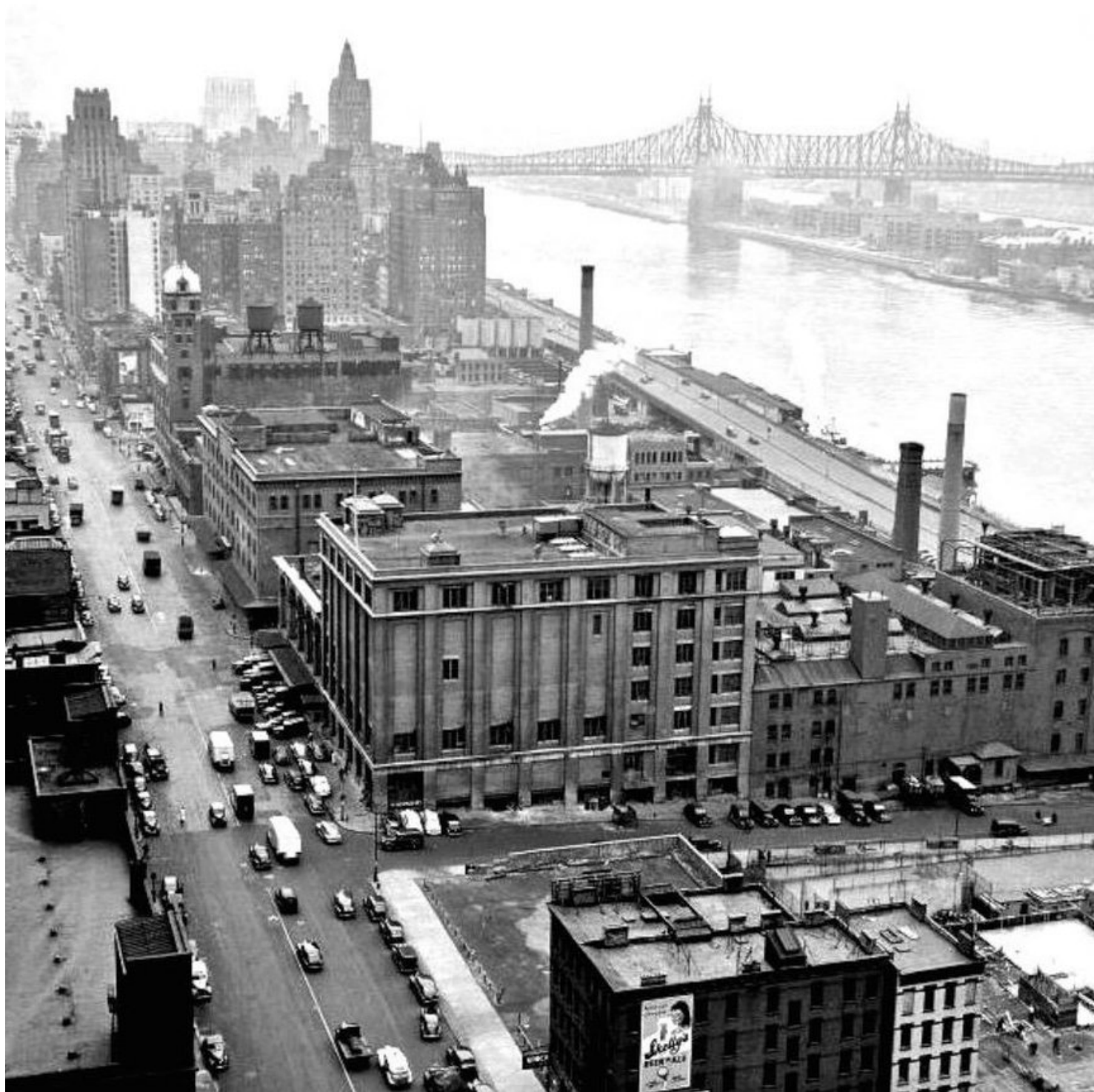
Brownfield pro budoucí umístění budovy OSN.
