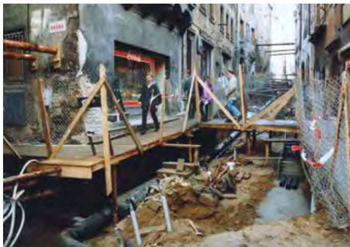
1998 – pokládání inženýrských sítí v centru města
