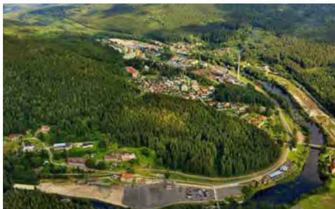
Loučovice - plochu obce tvoří 37%, dnes již z části asanovaných, brownfieldů
