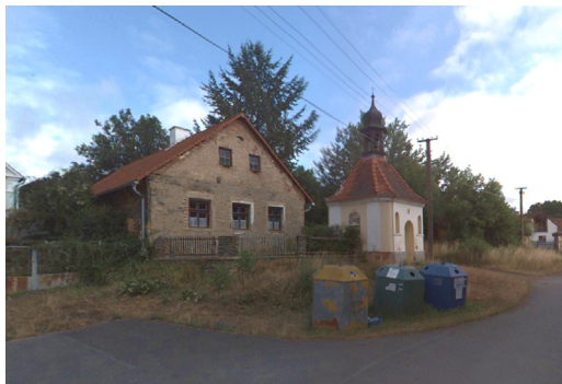
Nevhodné umístění kontejnerů pro tříděný odpad přímo před kaplí na návsi zdroj: mapy.cz
