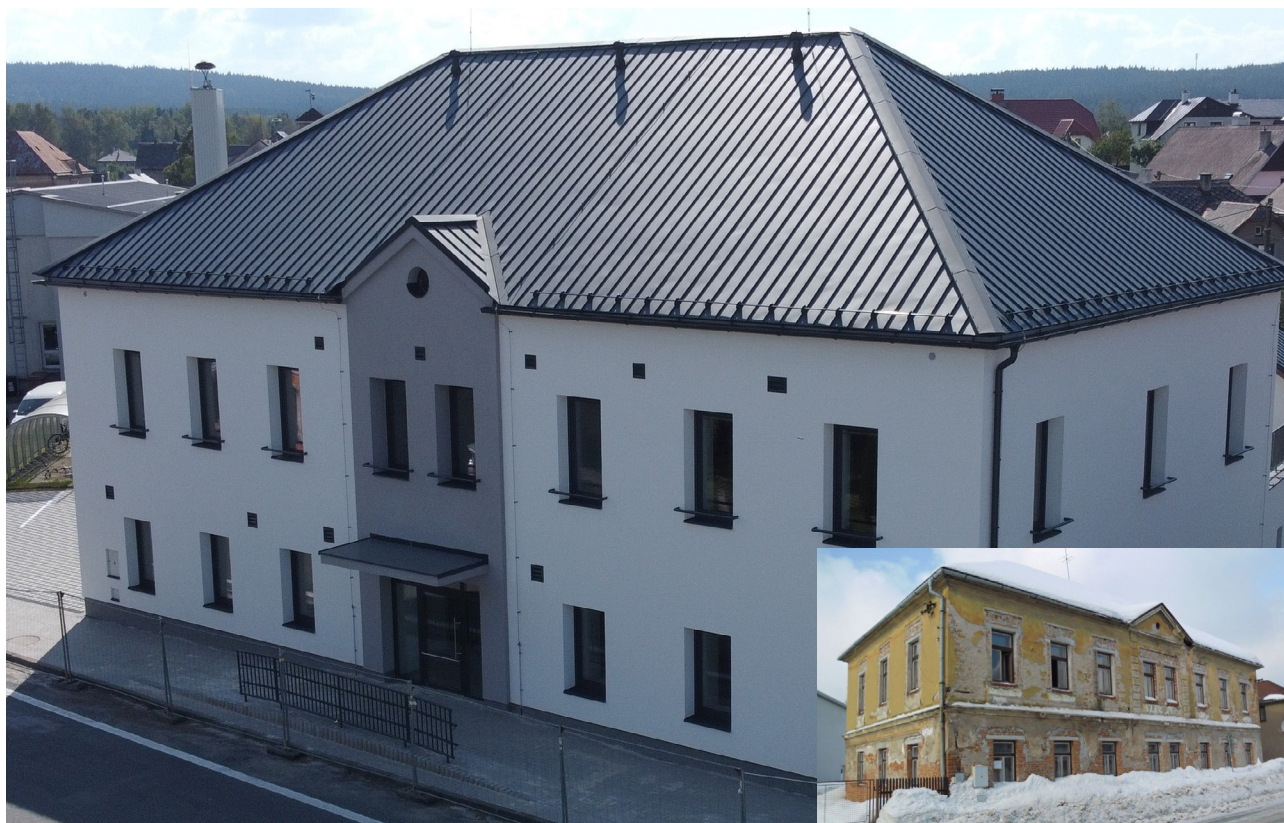
Obec Herálec získala podporu z programu MPO na přeměnu historické budovy v moderní multifukční objekt. Stav před a po přeměně. Zdroj: Herálec
