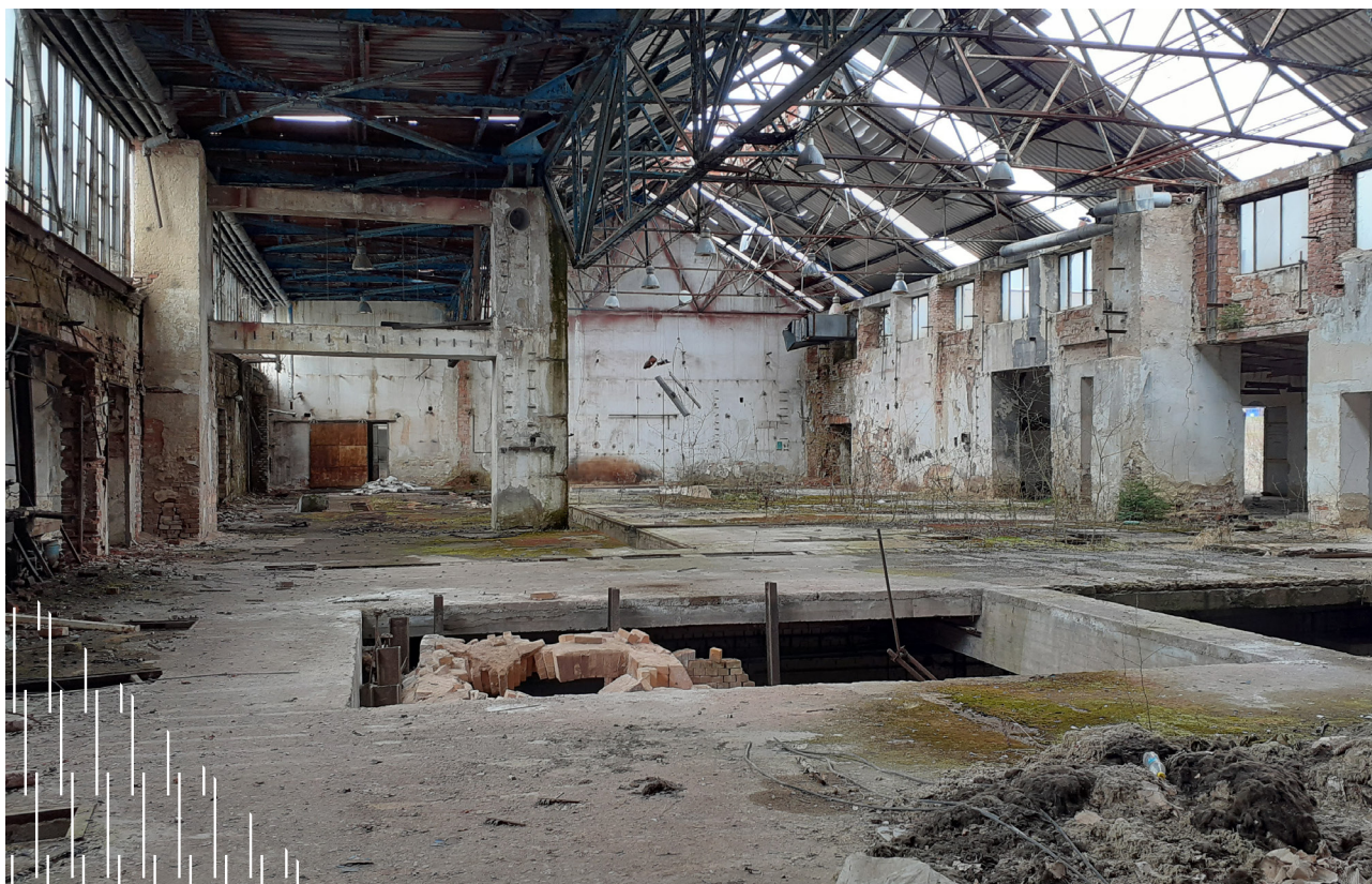
Bývalá sklárna Lenora. Jihočeský kraj. Zdroj: CzechInvest
