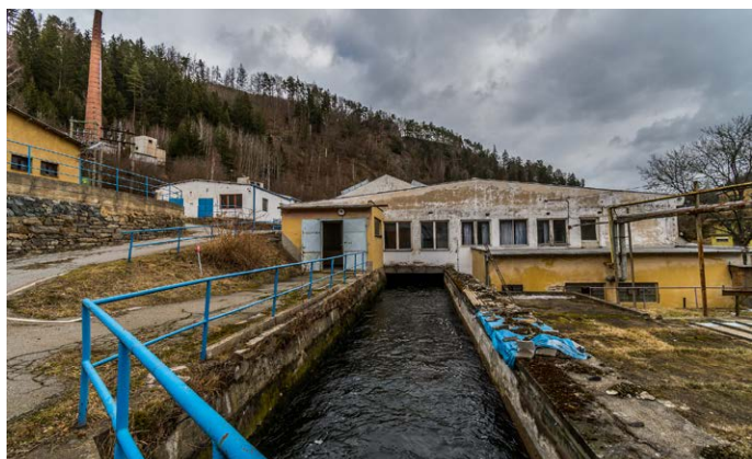
Náhon k MVE – budoucí vstup do konferenčních prostor
