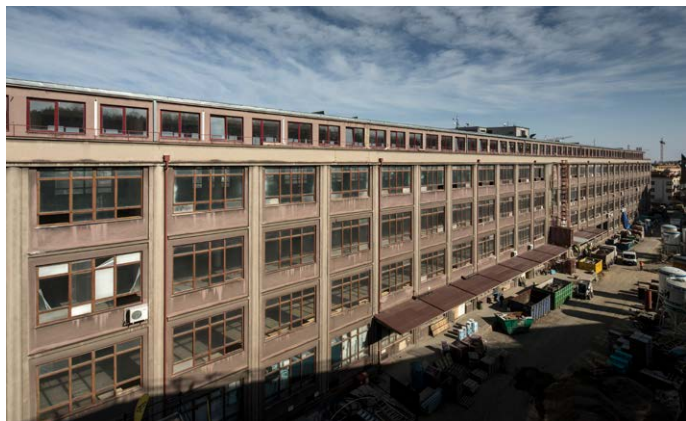
Areal Telus – bývalá továrna Meopta, stav před rekonstrukcí; zdroj: Česká rada pro šetrné budovy
