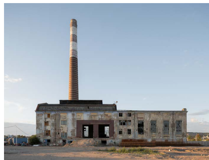
Kotelna v areálu Nové Zbrojovky; foto: Alex Shoots Buildings
