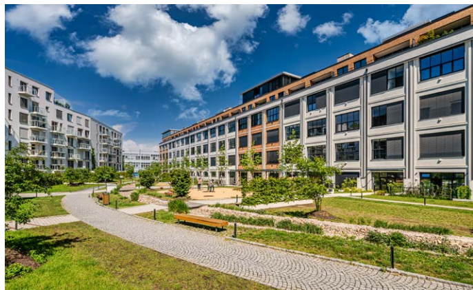
Stav po konverzi bývalé továrny Meopta a dostavba nového bytového domu; zdroj: Česká rada pro šetrné budovy
