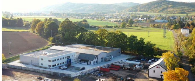
Současný stav areálu
